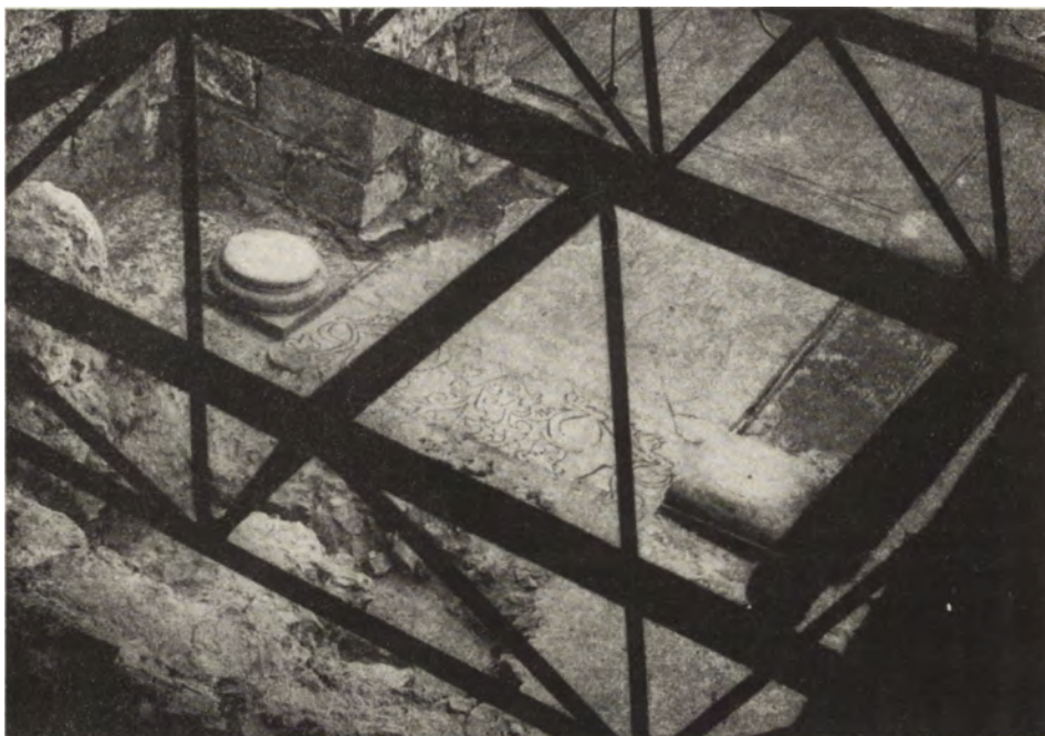
Kolegiata wiślicka. Wnętrze odkrytej krypty romańskiej widziane przez elementy konstrukcji rozpierającej mury prezbiterium.
