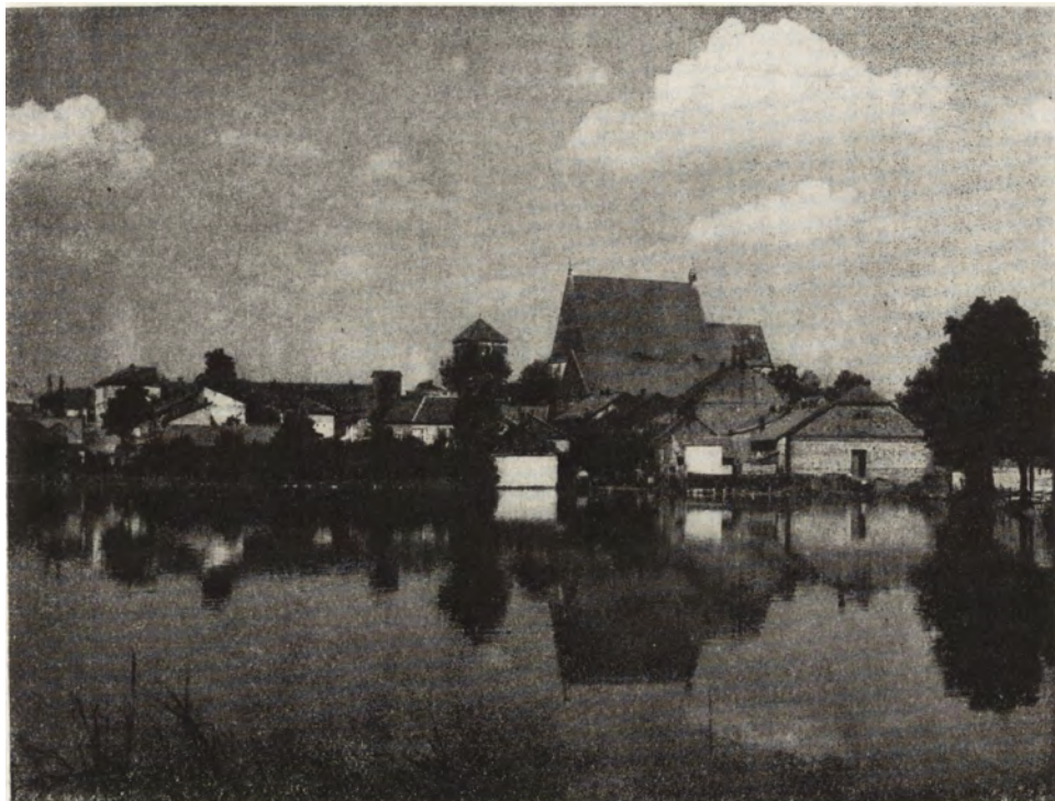
Bryły budowli zespołu kolegiackiego w Wiślicy w sylwecie miasteczka. Zdjęcie w czasie powodzi.
